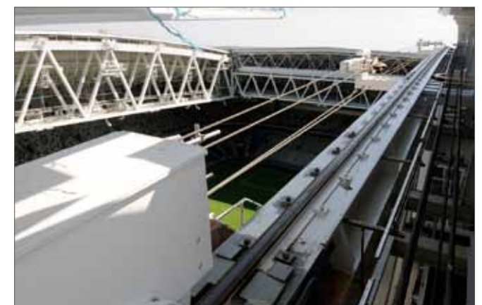
Bild 1 (links) zeigt den berührungslosen Linear-Encoder POMUX KH53 von Sick Stegmann. In den Bildern 2 und 3 wird der Linear-Encoder beim Einsatz für die Positionierung einer beweglichen Dachkonstruktion in der Tele2 Arena in Stockholm dargestellt. Das Fußballstadion verfügt über ein schließbares Dach (Quellen: SICK Stegmann).
